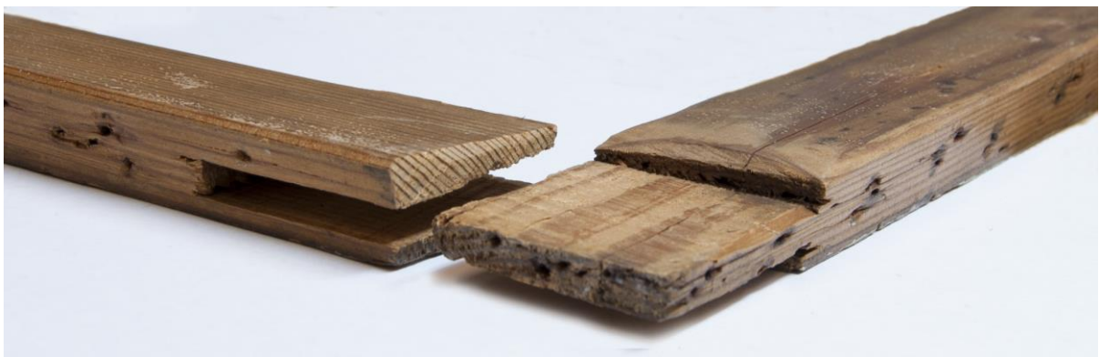
III. 11 Hjørneløsning i sliss og tapp.
