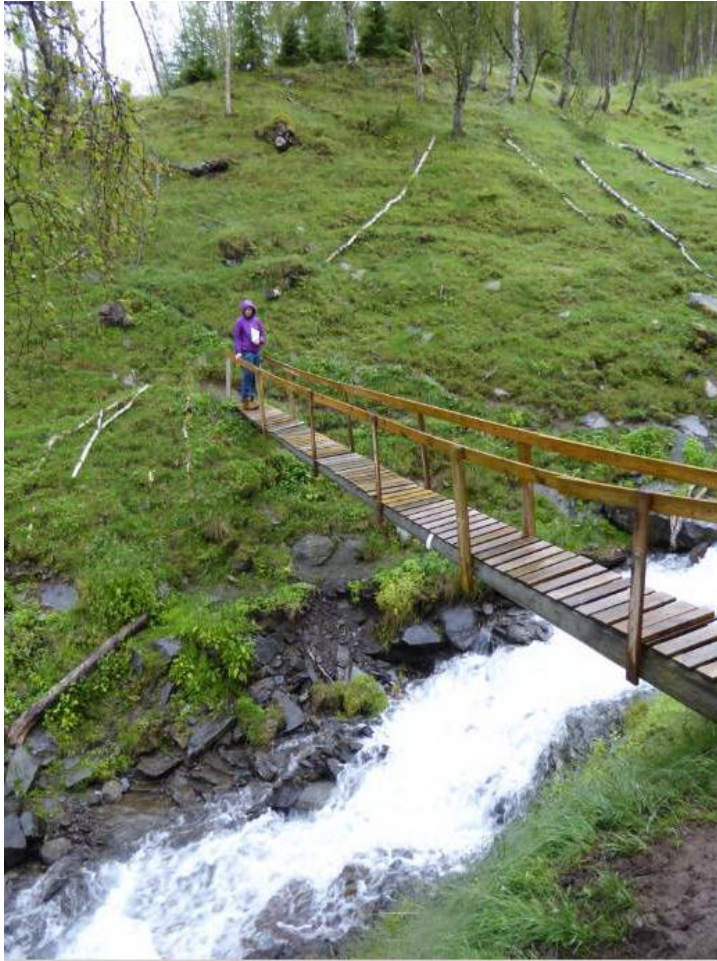
Figur 31: Bro over elva som ble laget i 2011, da den forrige ble ødelagt i skredet. På kote 235. Foto: Erik Hestnes, 02.08.2015.
