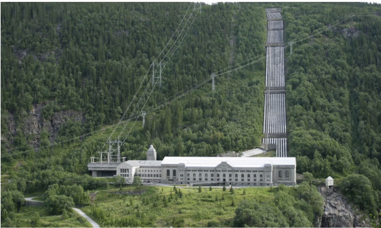
Bilde 11: Vemork kraftstasjon med rørgater. 2003. Man ser starten på juvet der Rjukanfossen en gang var til høyre for bygget. Foto: Norsk Hydro.
