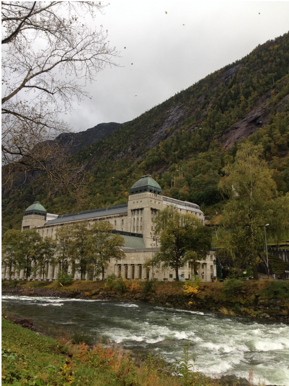
Bilde 9: Saaheim kraftstasjon på Saaheimsletten. 2015. Stasjonen er tegnet av Olaf Nordhagen og Thorvald Astrup, og ble ferdigstilt i 1915. Foto: Carl J. J. Leegaard
