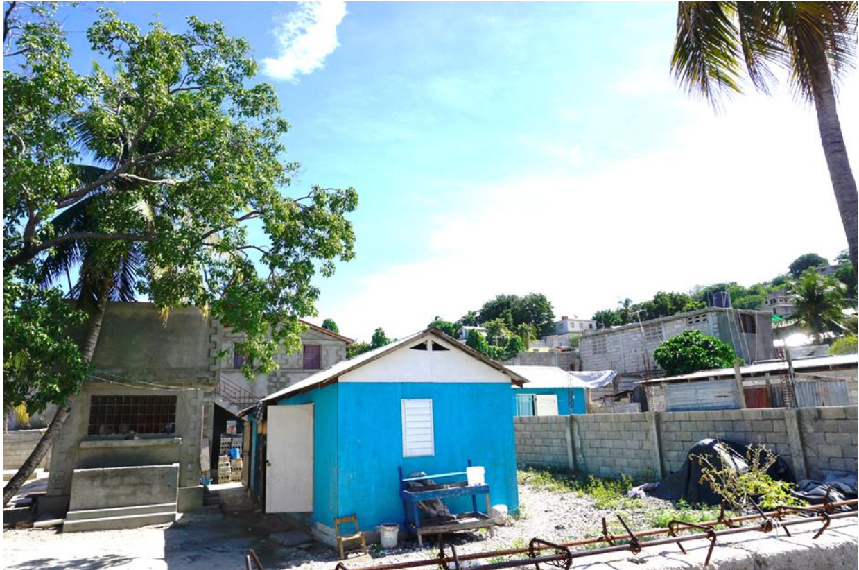
Photo 5 L'un des T-shelters construits par la CRF à Delmas 7. Ici habite une famille de cinq personnes. Maison en béton construite à gauche. Photo prise par l'auteur de ce mémoire.
