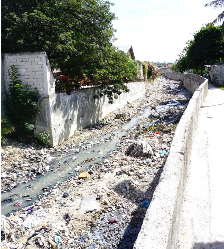
Photo 4 Le canal d'évacuation d'eau qui traverse Delmas 7 à 13. Photo prise par l'auteur de ce mémoire.
