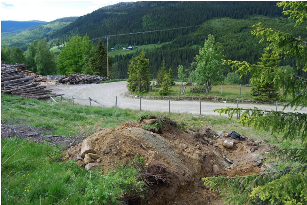
Schaktet genom S1, översikt. Sett mot syd.
