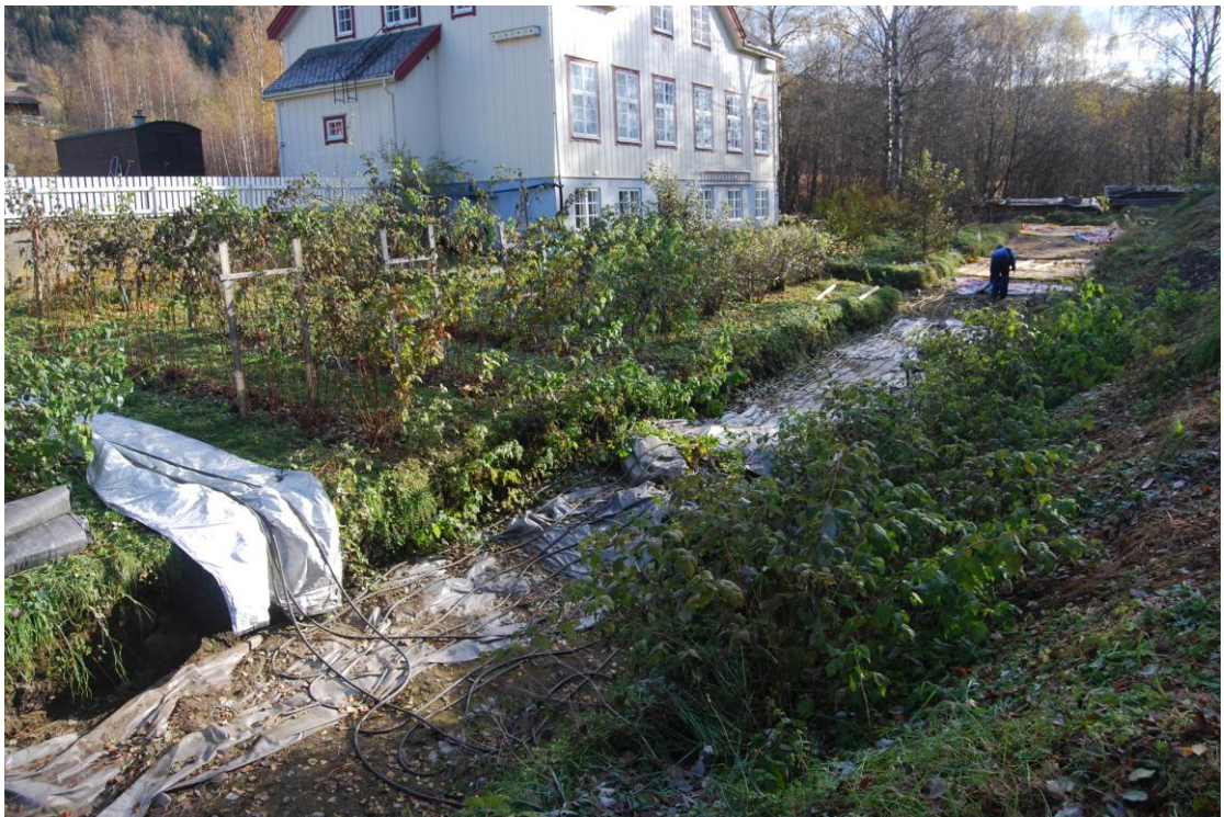
Figur 4: Hovedområde i sjakt 1a, før oppstart. Sjaktene ble tint med varmtvannførende slanger lagt over fiberduk, over ble det lagt isolerende presenninger. Sett mot sørøst (cf34142_01) (foto: AJN).
