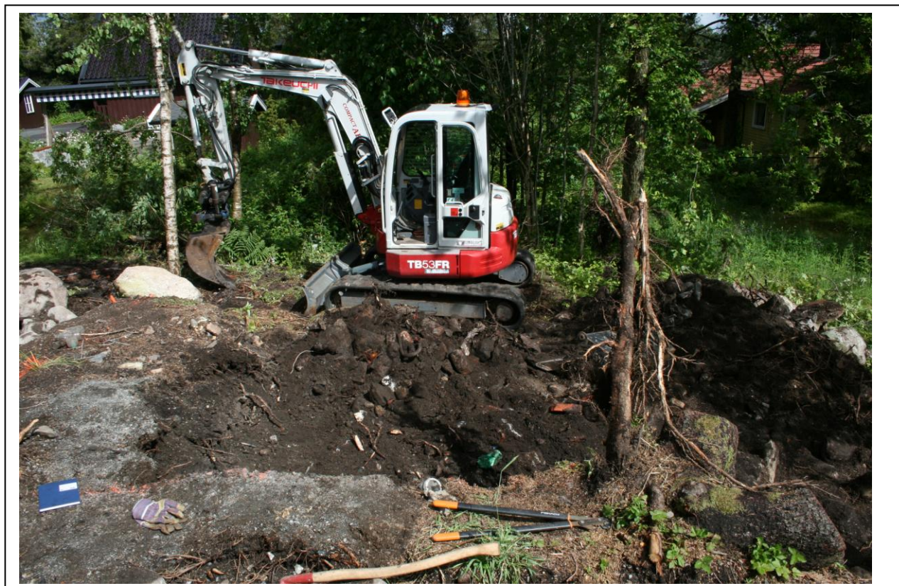
Fig. 12: Gravemaskin (5-tonns med belter) var et helt nødvendig hjelpemiddel for å fjerne de til dels tykke laga av sekundært påførte fyllmasser oppå røysa, i hovedsak avfall fra tida da huset på eiendommen blei oppført omkring 1960. Her i nordøstre kvadrant av røysa. Mot nord. Foto: G. Reitan/KHM.
