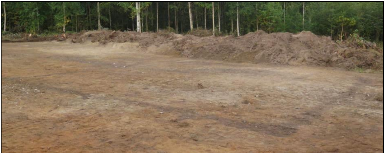
Figur 8: Større grøftesystem sett mot vest, (foto cf34793_8).
