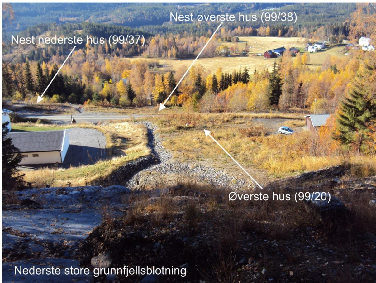
Figur 8.36 Utsyn utover nederste del av skredet fra den nedre store grunnfjellsblotning. De tre husene 99/20, 99/37 og 99/38 er fjernet og det er opprettet nytt dreneringsmønster fra nederste store grunnfjellsblotning og ned til E16.
