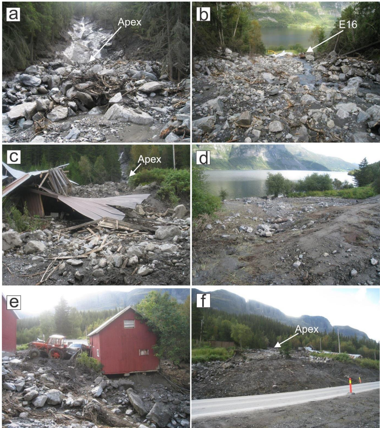
Figur 8.44 Avsetningsområdet i skredløp nr. 1, like etter skredhendelsen. a) Viser apex hvor avsetningen startet, b) avsetningene sett fra apex og nedover skredløpet, c) Garasjen som ble tatt av skredet like ovenfor E16, d) avsetningene nedenfor E16, e) ødeleggelsene på tomte nedenfor E16 og f) utsikt oppover skredvifta med E16 i forgrunnen (apex er markert) (private bilder fra Thomas Sletten).
