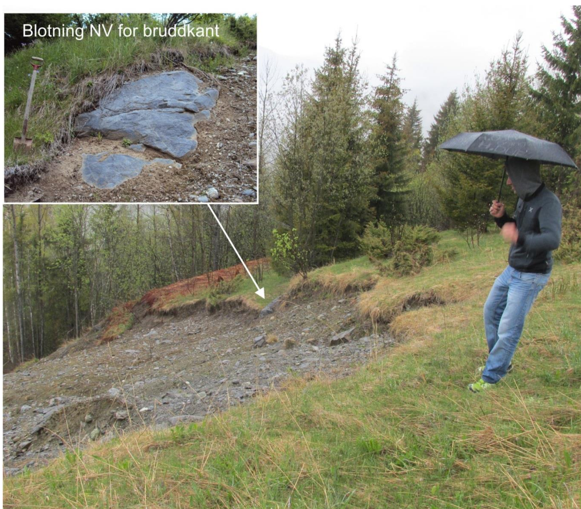
Figur 8.31 Bruddsonen til jordskredet. Blokk eller grunnfjell er blottlagt på NV-siden av denne bruddkanten og denne inneholder tre sprekkesett.
