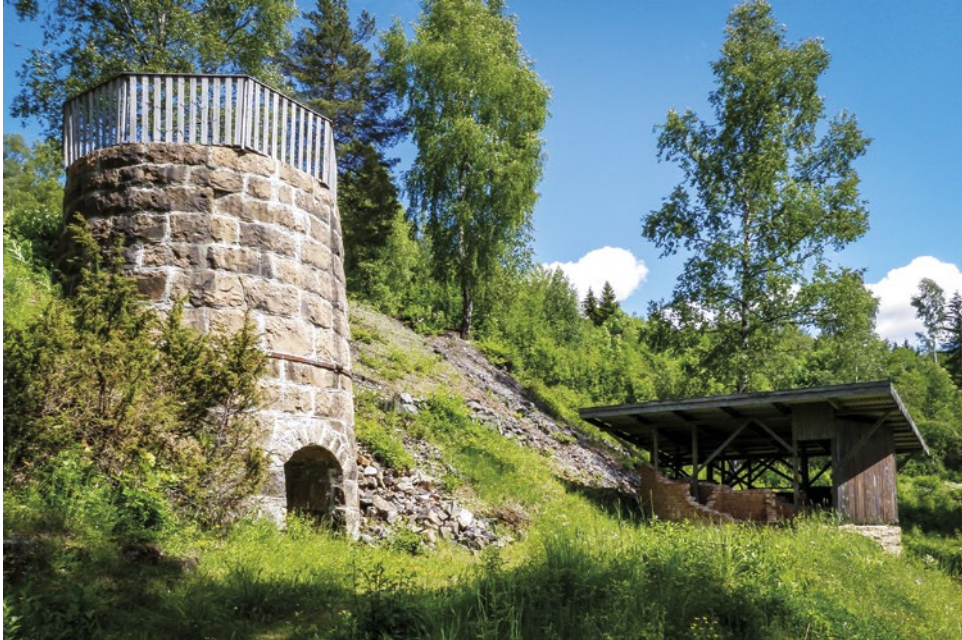
Figur 2. Mange geologiske ressurser er utnyttet i Gruaområdet, bl.a. kalk. Foto: Unni T. Grøtberg.
