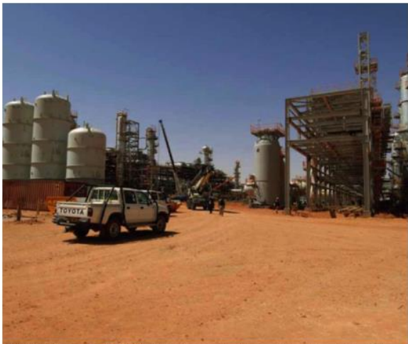
ANLEGGET: Anviklede av gassanlegget i In Amenas i Algerie, der Statoil er en av operatørene. Flere personer ble bortført et angrep på anlegget onsdag. FOTO: SCANPIX
