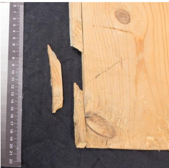
Figur 26: To deler av det nedre bordet hadde løsnet.
