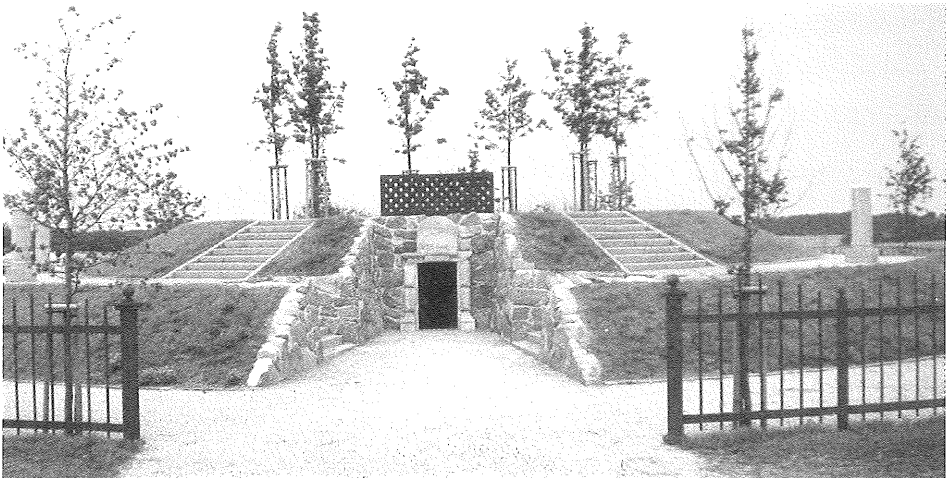
Fig. 12. Julianehøj etter restaureringen 1984. I forgrunnen inngangspartiet med minneplaten til ære for enkedronning Juliane Marie, Kong Frederik V's andre hustru. Etter Thorsen 1985a.
