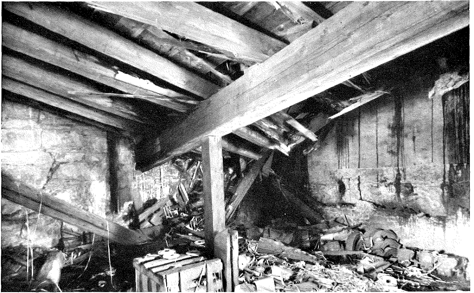
Tårnet innvendig etter katastrofen. 1. Vestre del med utrevet hjørne. Like over rasmassene skimtes de gamle vindusbuene til „Kongens kammer“ (se tekstfig. 4). — 2. Rasmassene i Rosenkrantz' tilbygg mot nordøst. — 3. Taket i rommet over den nyere inngangshallen knekket under raset. Midtstolpen holder. Den er slått ned på hvelvet.
