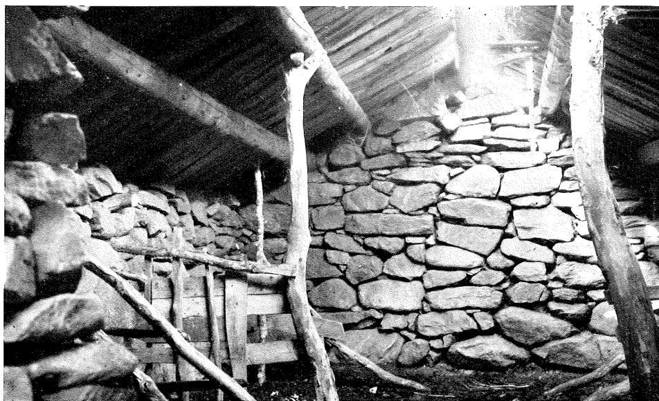
1—2. Eksteriør og interiør av steinhus på Kyrkjestølane på Filefjell med stolpekonstruksjon for taket. Brukes nå til sauefjøs. Tidligere bruktes lignende hus til selve selet. B. Hougen fot.
