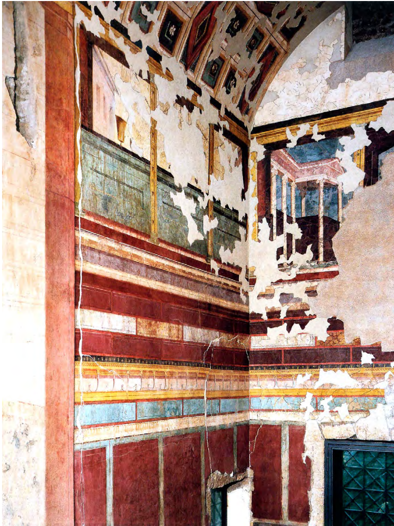
Fig. 4. Oktavians hus, rampen, NV- og SV-veggene (Iacopi 2007, fig. s. 59 t.h.).
