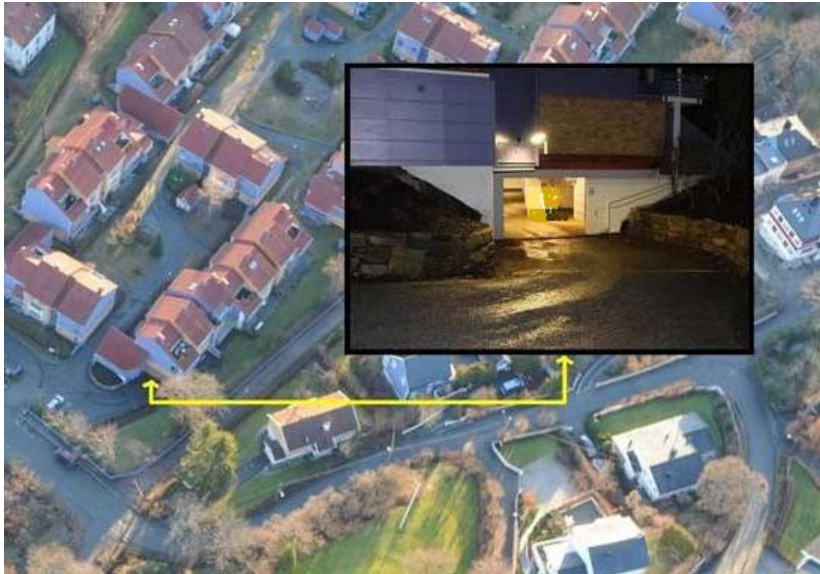
Illustrasjon 6. Oversiktsbilde med utsnitt som viser innkjøring til det aktuelle garasjeanlegget.
