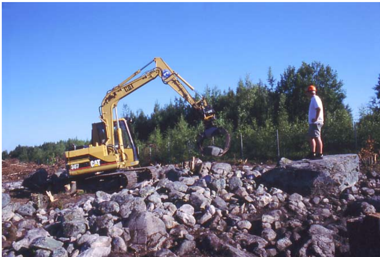
Figur 5_3: Fjerning av stein ved hjelp av gravemaskin med gripekle. Foto: E6-prosjektet Østfold, Kulturhistorisk museum.
