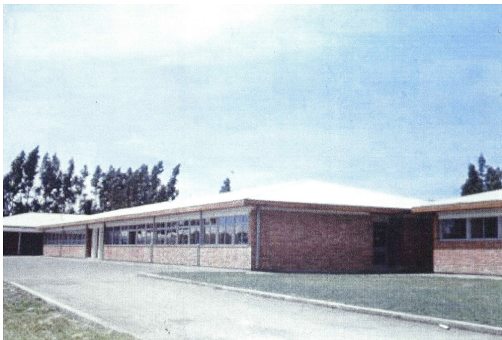
Figur 4: Den opprinnelige laboratoriebygningen
