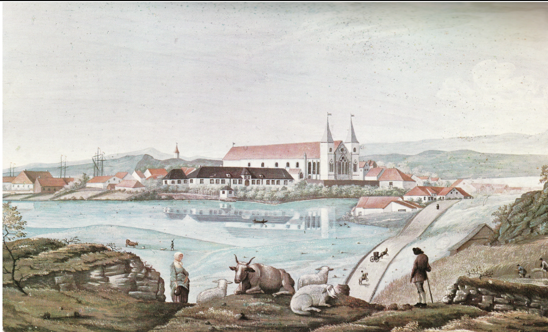
"Stavanger med sin kirke (en af de smukkeste i Landet siger man), falder ingensted fuldkommere og bedre i Øiet end her - Bredevandet og paa den ene Side deraf Kongsgaard, en smuk Træbygning, opført for Kongelig Regning paa Fundamenterne af den murede Bygning, der bar Navn af gamle Kongsgaard og fra først af har været den berømte Bisperesidentse, som Peder Clausen nævner i sin Norges Beskrivelse - omkring den er anlagt en Have, som, skjønt den største i disse Egne, dog fortjener mere at nævnes for sin Skjønhed end Størrelse" (Zetlitz 1969: 62). Slik beskriver Zetlitz byen fra utsiktspunktet på Egenæs hvor bildet er malt. I bakgrunnen skimtes det åttekantede Valbergtårnet 50 på byfjellet. Den gamle Kongeveien ses til høyre. Bildet hang tidligere på Ledaal og er laget av amtmann Scheel ca 1793. I dag tilhører det Stavanger Museum.
