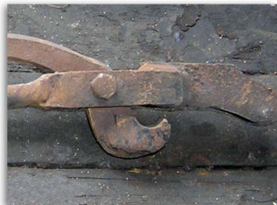
Figur 6. Spesialtang med synlige sveiseskjøter. Eget foto.
