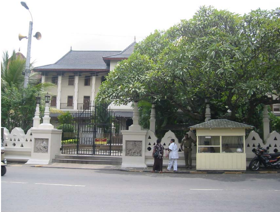
VIP-inngangen fra sør.
