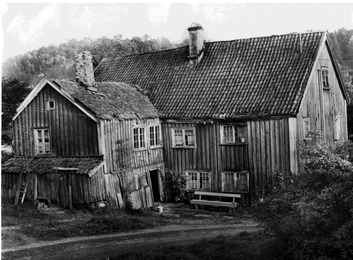
Bilde nr 7. Strømmenhuset sett fra baksiden. Huset ble fotografert i forbindelse med en avisartikkel i lokalavisen TIDEN, hvor det ble protestert mot rivingen. Som bildet viser var forfallet stort. Syrinbuskene til høyre i bildet finnes fremdeles. Fotograf: Arne Michael Olsen, 1962. AAKs. Øyestad-bilde nr 162.
