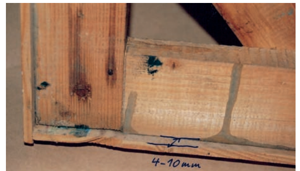
Figur 27. Detalj fra blindramme under tilpassning i 2008. Fingermerker i maling og rennemerker fra lim. Foto: Walfried Brandt.
