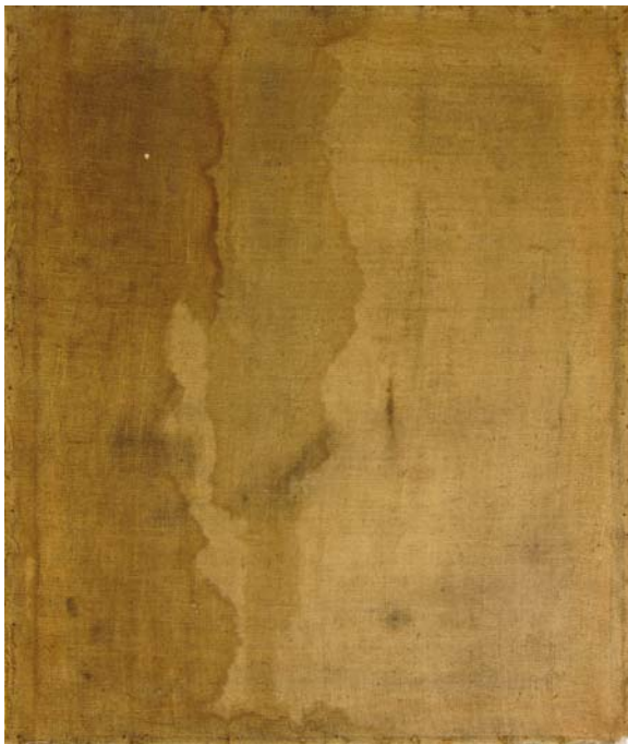
Figur 16 Baksiden av dubleringslerretet.
