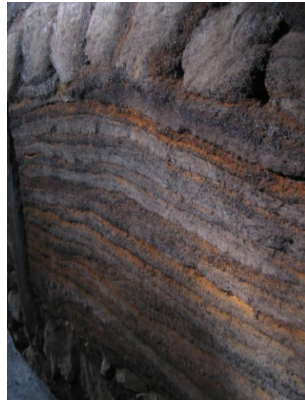
Figur 18. Vegg bygget av strengur på fundament av stein. Foto: Marianne Hem Eriksen
