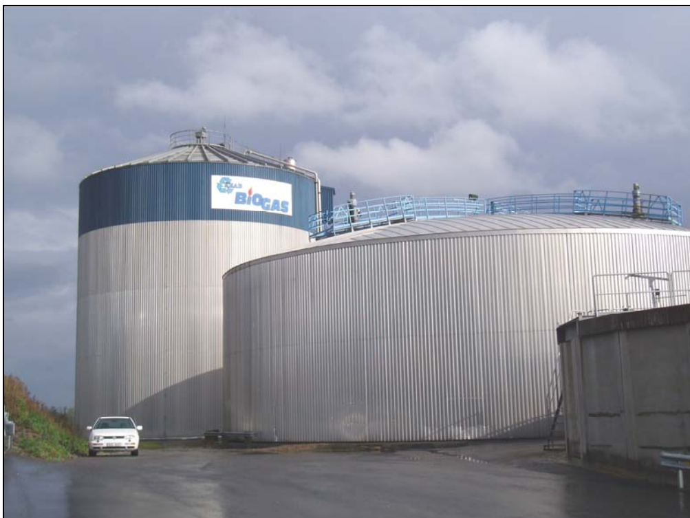
Figur 9: Biogassanlegget i Kristianstad.
