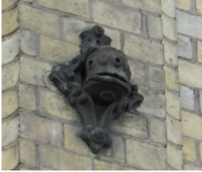
Veggrosett fra Grøntrikken på Stortingsbygningen mot Karl Johans gate.
