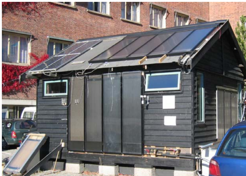
Figur 5.1: Bilde av sol-laben. Forsøkene er utført på de fem solfangerne på høyre side av taket. PV-cellene til venstre og solfangerne på bakken og begge vegger er benyttet i andre forsøk.
