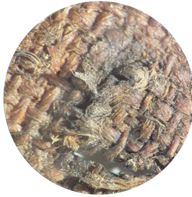
Figur 49 Rift i lerretet før reparasjon
