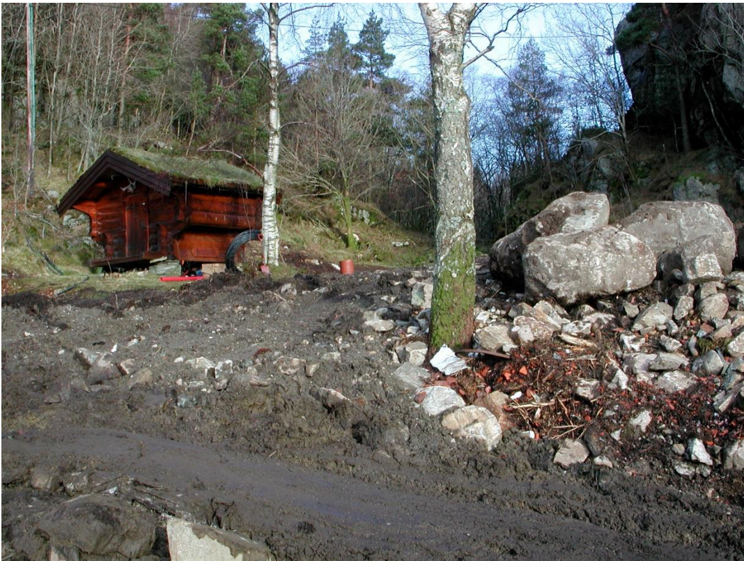
Figur 8: Bilde fra anleggsprosessen i 2008. Foto: Rune Aksland
