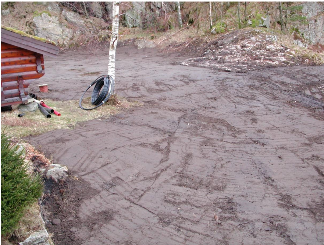
Figur 10: Bilde fra anleggsprosessen i 2008. Foto: Rune Aksland
