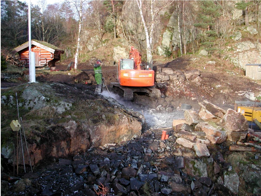
Figur 7: Bilde fra anleggsprosessen i 2008. Foto: Rune Aksland
