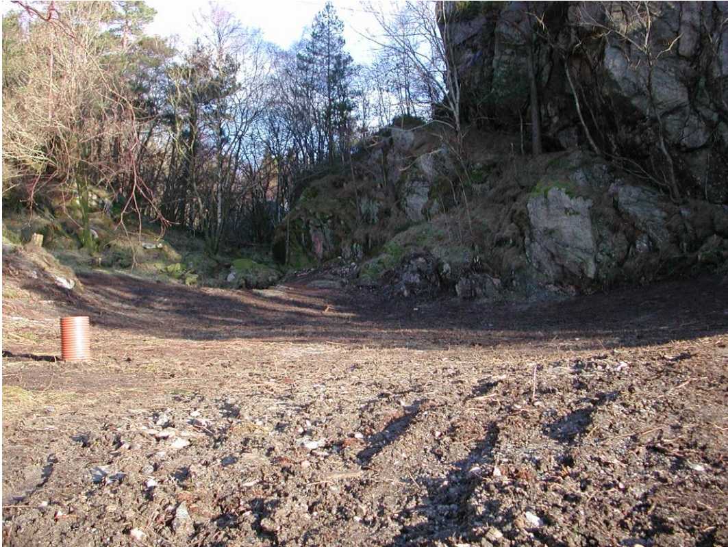
Figur 9: Bilde fra anleggsprosessen i 2008. Foto: Rune Aksland
