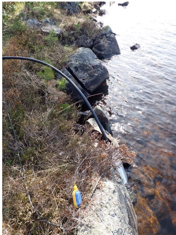
Figur 4: Brønnpumpe i vannkanten for tilførsel av vann til såldestasjon. Vann ble pumpet opp fra Ofte vann via en brønnpumpe tilknyttet et aggregat. Aggregatet ble koblet til pumpen med en skjoteledning, dette fungerte svært godt med unntak av at aggregatet brukte til dels mye drivstoff og tidvis hadde vi problemer med å starte det. Sett mot sør (Cf53969_011). Fotograf C. S. Rosenvinge.
