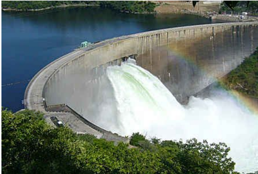
Figur 4.5: Kariba-dammen i Zimbabwe/Zambia utløste en rekke jordskjelv i 1963 da den fyltes. Tjue av disse hadde en styrke på over 5, og det største var på 6.2. Bildet er hentet fra [2].
