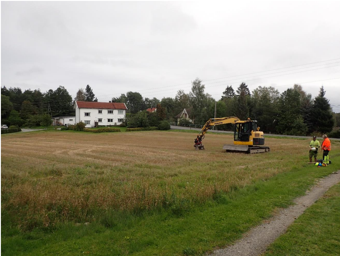
Figur 2: Lokaltet 1 før oppstart. Hus 1 og 2 lå bak gravemaskinen til høyre i bildet, hus 8 helt til venstre. Foto mot NØ. Fotograf: John A. M. Havstein.
