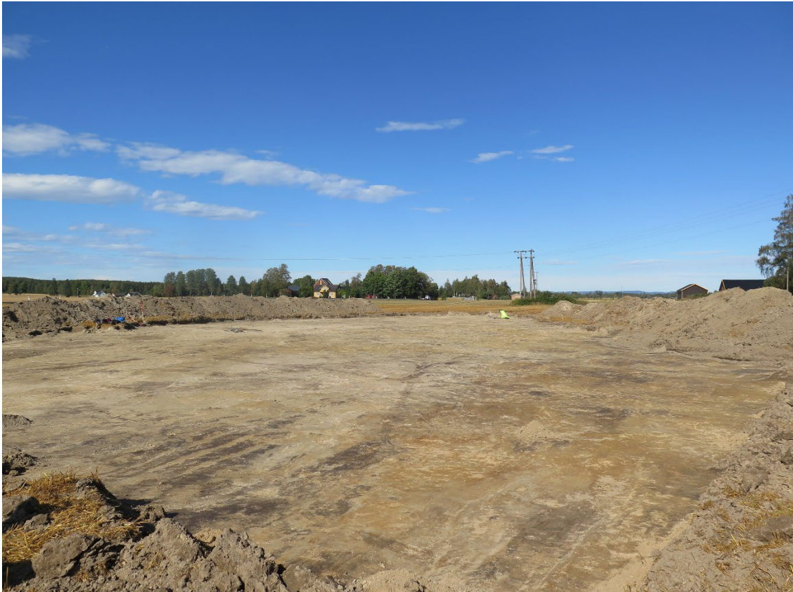
Figur 4. Ferdig avdekt felt. Sett mot nord. Foto Julian Post-Melbye
