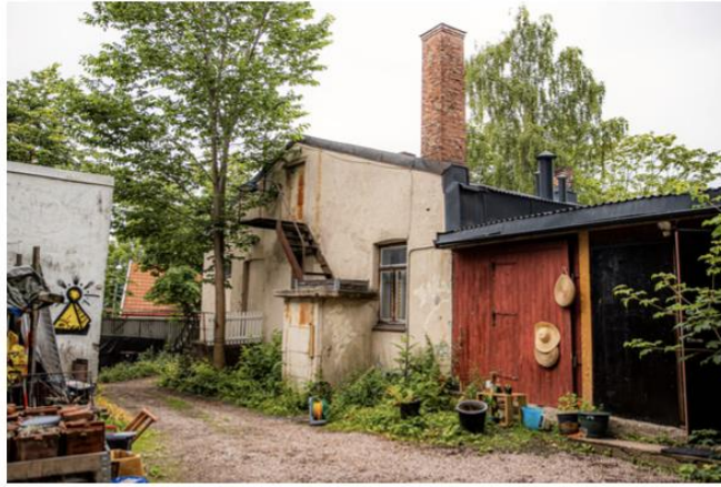
I kjelleren på denne bygningene lå i sin tid skismurningsfabrikken Bratlie. Den skal nå bevares - og bli til to boliger. Foto: Stein J. Bjørge
