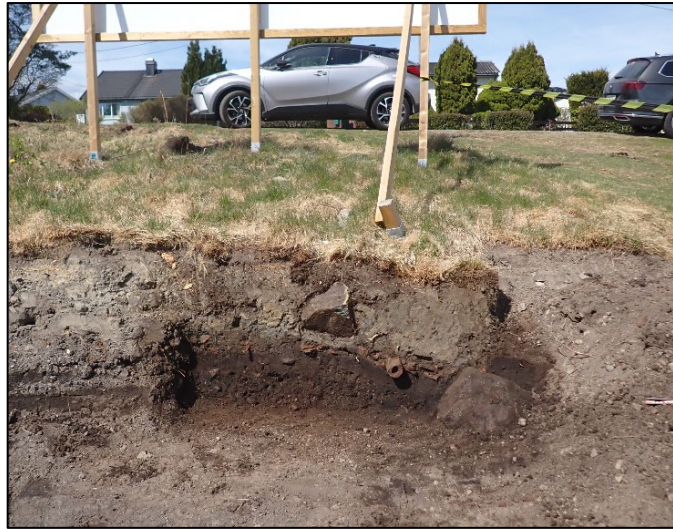
Figur 14: Profil som viser påfylte masser i nordre del av feltet.
