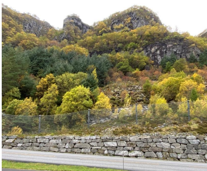
Figur 19: Fjellsiden i Barstadvika. Langs veien er det satt opp steinspranggjerdje og tørrmur med skråning bak mot opprinnelig terreng. Bildet tatt i felt 3. oktober 2022.
