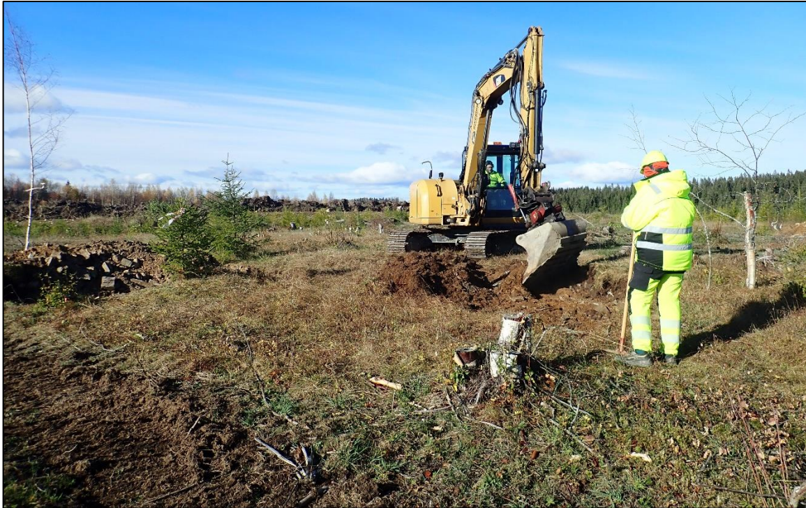
Figur 4: Arbeidsbilde av Karin K. Lindboe og gravemaskin som er i gang med å undersøke en av rydningsrøysene. Foto: Ellen Kathrine Friis, Cf53976_026.
