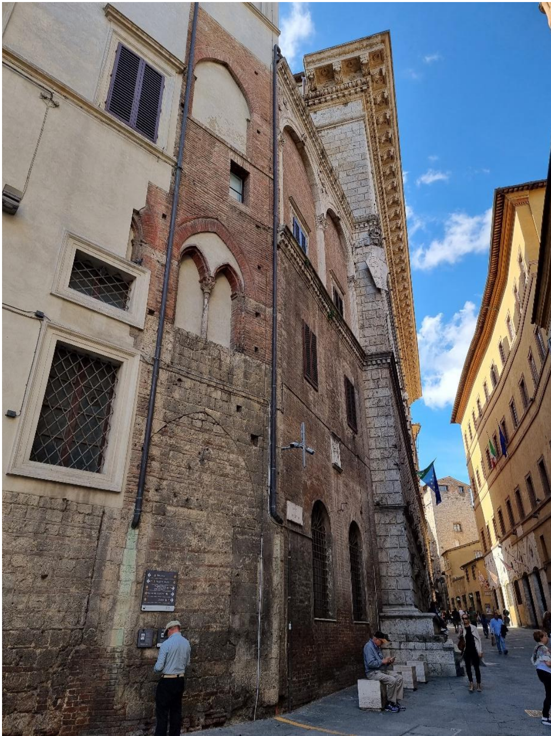
Illustrasjon 17. Detalj øverst ved den avkuttete gesimsen. Palazzo Todeschini-Piccolomini . Siena. Eget fotografi, 2022.
