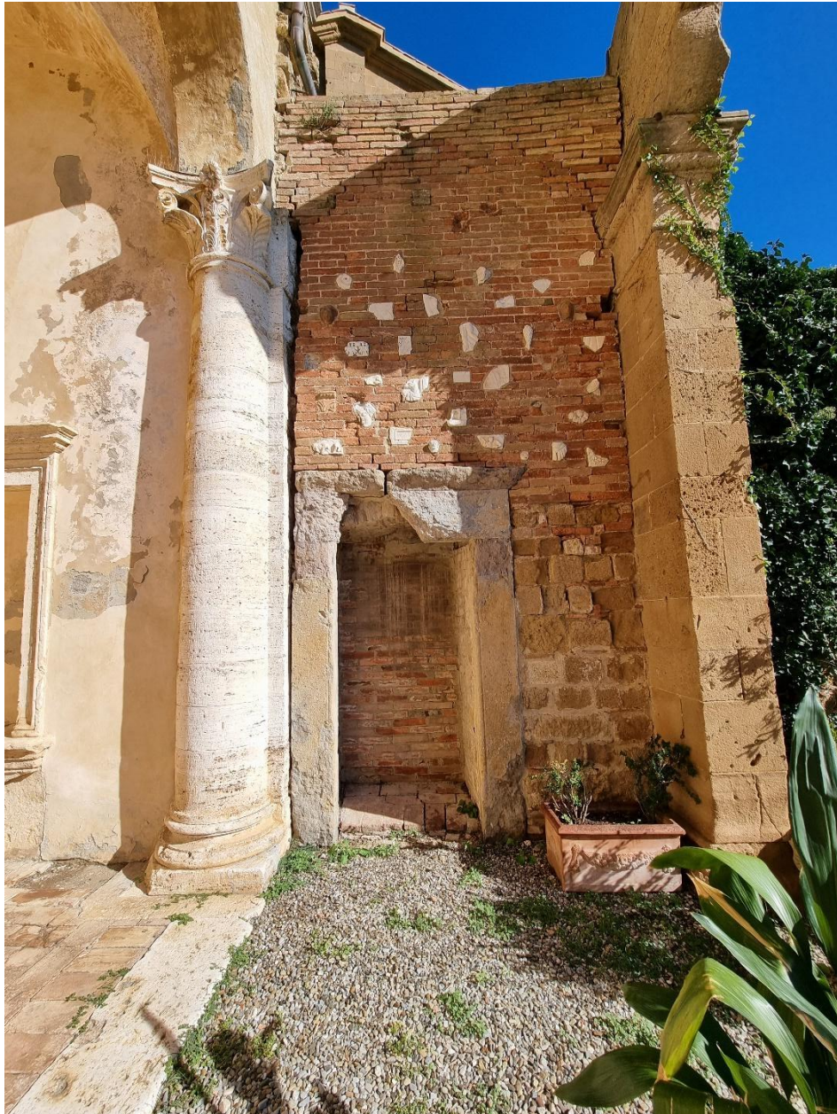
Illustrasjon 29. Deler av inngangspartiet til Pius II barndomshjem i lys stein som er murt inn av røde mursteiner. Spolia i mursteinen er av nyere dato, ca. 1500. Palazzo Piccolomini . Pienza. Eget fotografi, høsten 2022.
