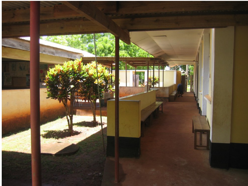
Figur 3.4: Et distriktssykehus på Zanzibar
